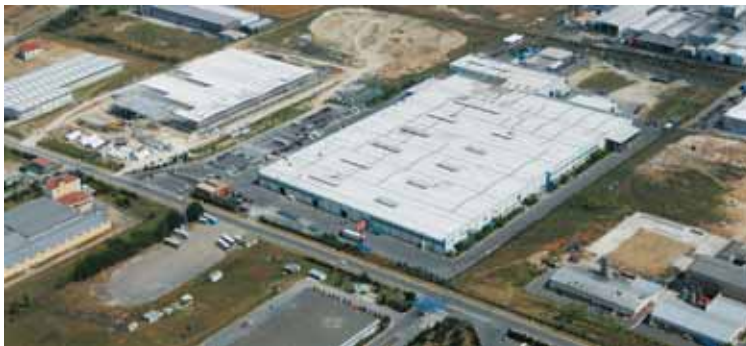
Çamaşır Kurutma Makinesi ve Elektrik Motorları İşletmeleri Çerkezköy, Tekirdağ
