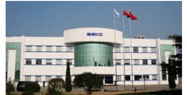
Beko Electrical Appliances Çamaşır Makinesi Üretim Tesisi Çin
