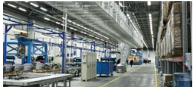
Beko LLC Buzdolabı ve Çamaşır Makinesi Üretim Tesisi-Rusya
