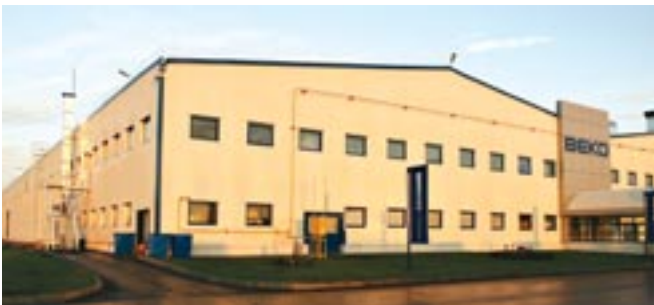
Beko LLC Buzdolabı ve Çamaşır Makinesi Üretim Tesisi-Rusya
